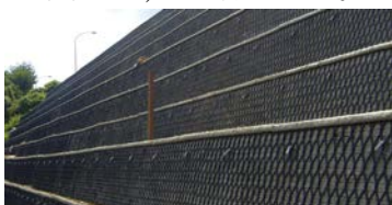
写真1 ジオテキスタイル補強土
