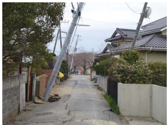
写真1 東北地方太平洋沖地震による佐原市の液状化被害 (2011年4月3日、中井健太郎撮影)
